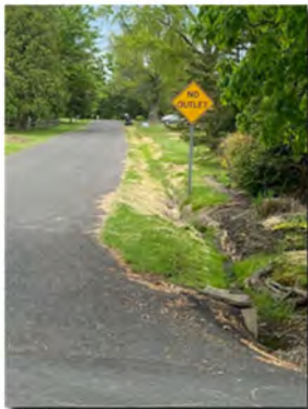
Helen Ln. ditching
